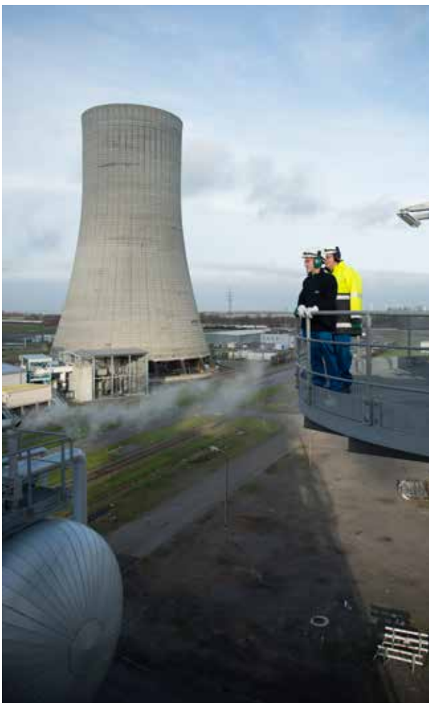
Twee medewerkers hebben een goed zicht op de koeltoren van Zandvliet Power.
