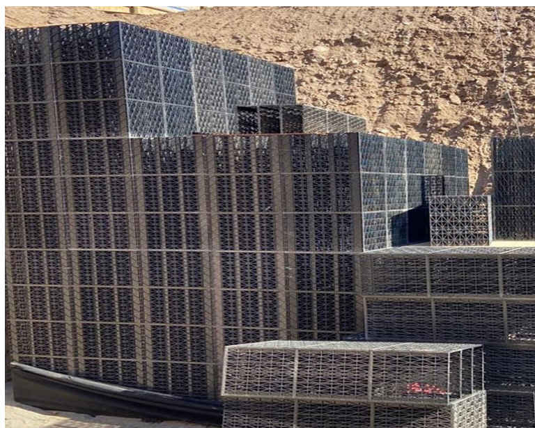
Figura 1: Caixas de engenharia utilizadas na construção civil. A principal função dessas caixas recicladas usadas na fundação é captar e drenar a água da chuva. Crédito: divulgação BASF.
