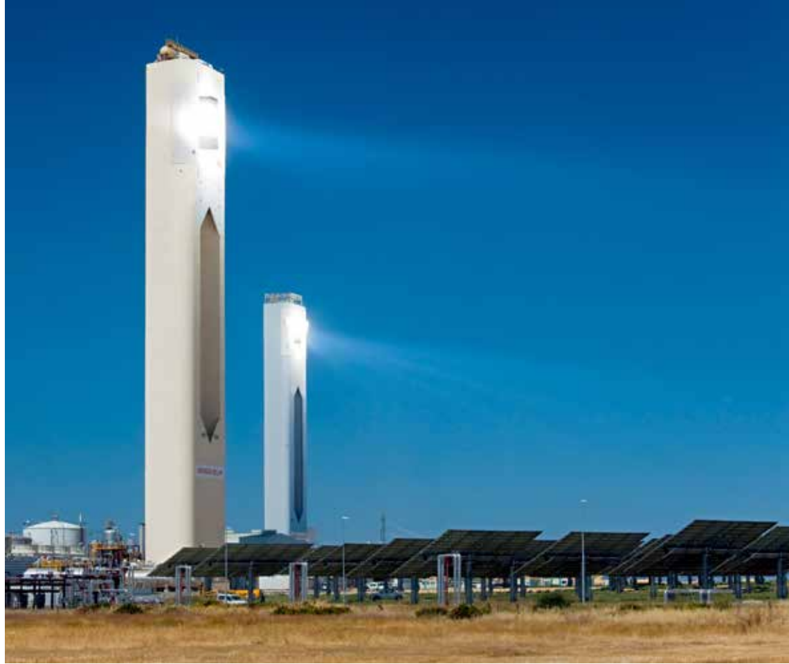
太阳能塔可以实现最高的热能效率。这座PS20太阳能塔属于位于西班牙塞维利亚的Abengoa Solar公司，装机容量为20兆瓦。
