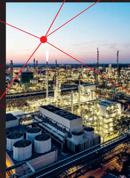
巴斯夫、沙特基础工业公司与林德集团合作，在其位于德国路德维希港基地建设全球首座大型电加热蒸汽裂解炉示范装置。
