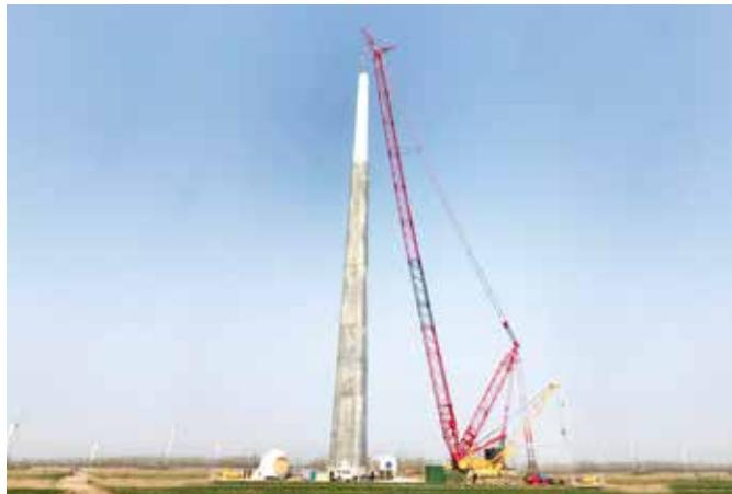
巴斯夫灌浆解决方案助力 120 米轮毂高度钢混塔筒成功吊装，标志着风电发动机组的技术发展又添一座里程碑。
