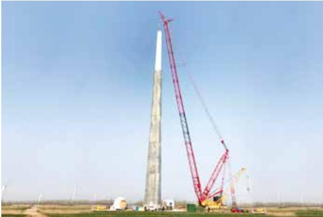
巴斯夫灌浆解决方案助力 120 米轮毂高度钢混塔筒成功吊装，标志着风电发电机组的技术发展又添一座里程碑。
