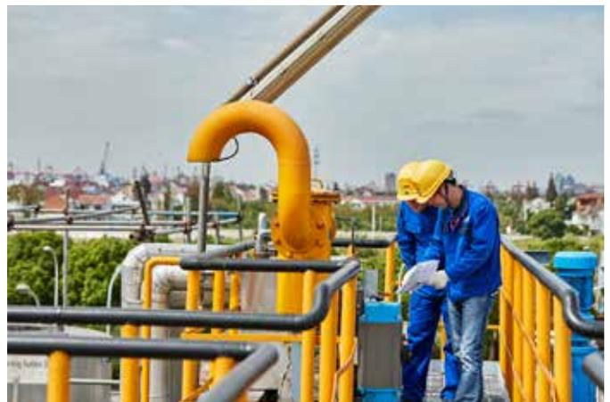
两名操作员正在检查废气排放点（橙色弯管）。废气在排出之前，已在装置内处理过。
