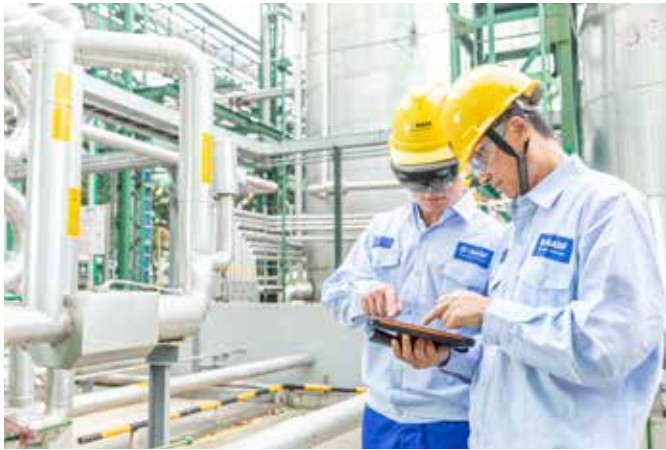
操作工利用数字化设备对装置进行常规检查以减少工艺安全事故。
