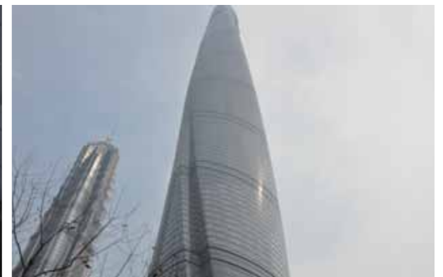
工程项目：上海中心大厦 解决方案：巴斯夫混凝土外加剂
