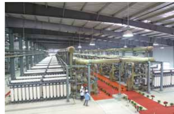
工程项目：曹妃甸海水淡化 解决方案：巴斯夫inge®dizzer®XL 0.9 MB 60W 膜元件 及T-Rack® 机架
