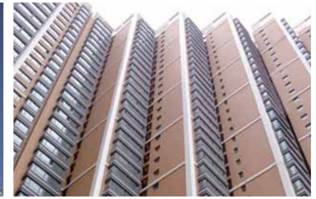
工程项目：青海西宁海德堡小镇二期 解决方案：巴斯夫凡士能® Styro-E外墙外保温及饰面系统
