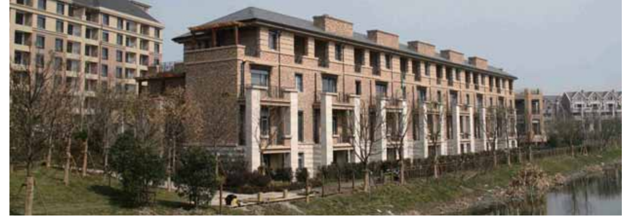
工程项目：朗诗绿岛 解决方案：巴斯夫凡士能® Neo外墙外保温及饰面系统以及Elastospray® CH 聚氨酯喷涂隔热保温方案
