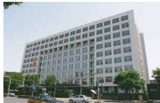
工程项目：国家教育部大楼 解决方案：巴斯夫Elastospray®CH聚氨酯喷涂隔热保温方案
