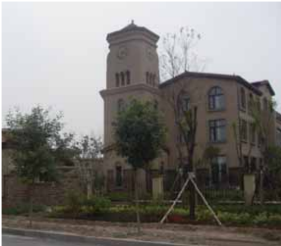
工程项目：山东滨州香溪翠亭别墅区 解决方案：巴斯夫Elastospray®CH 聚氨酯 喷涂隔热保温方案
