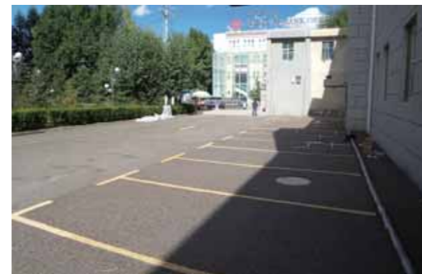
工程项目：西藏日喀则国税局停车场 解决方案：巴斯夫Elastopave®聚氨酯碎石透水路面
