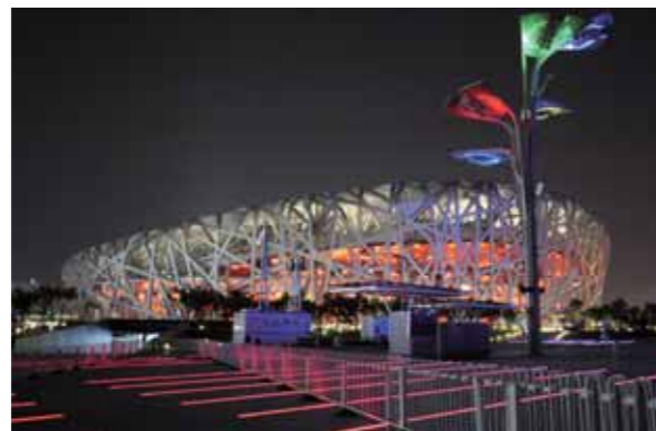
工程项目：北京奥运会鸟巢 解决方案：巴斯夫混凝土外加剂
