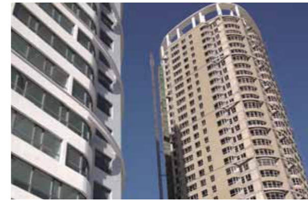
工程项目：青海西宁民惠城 解决方案：巴斯夫凡士能® Styro-E外墙外保温及饰面系统
