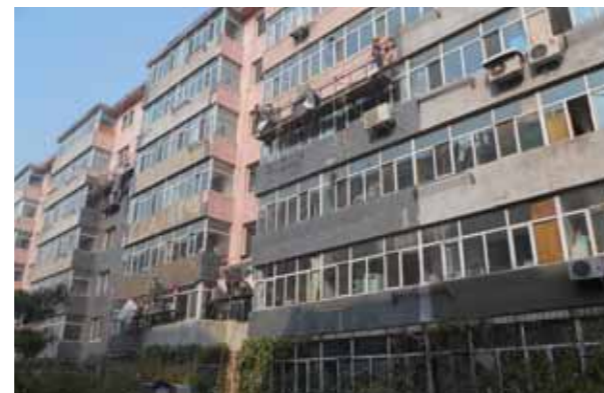
工程项目：沈阳暖房改造 解决方案：巴斯夫Neopor®创新泡沫隔热保温解决方案
