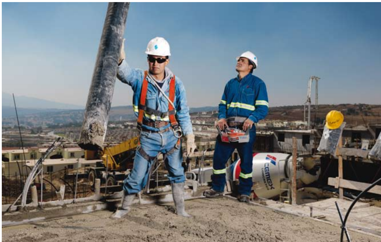
Unser Kunde Cemex baut in der Nähe von Mexiko City mit Hilfe von Betonzusatzmitteln der BASF Häuser für Familien mit geringem Einkommen.
