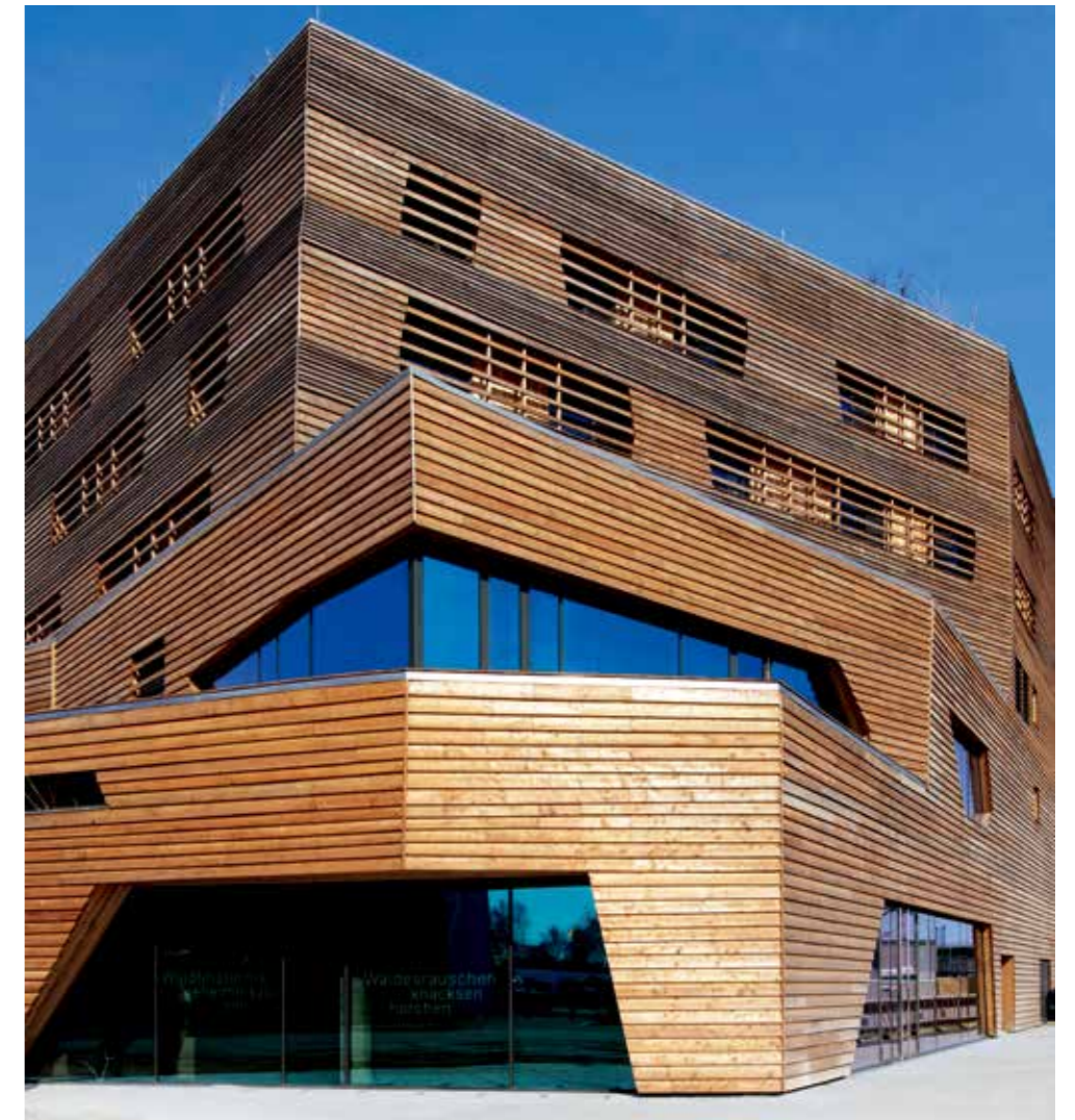
可持续建筑：汉堡 Walderhaus的木制立面，屋顶太阳能电池和高性能保温隔热材料。
