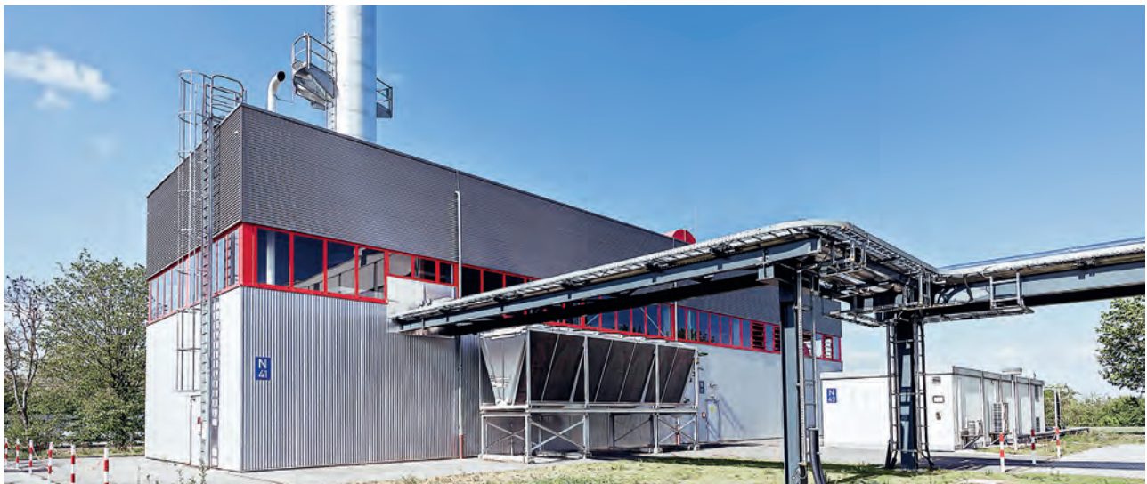
Kraftwärmekopplungsanlage am Standort Lampertheim
