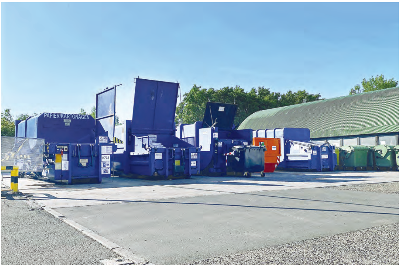
Sammlung fester Abfälle im Abfallzwischenlager
