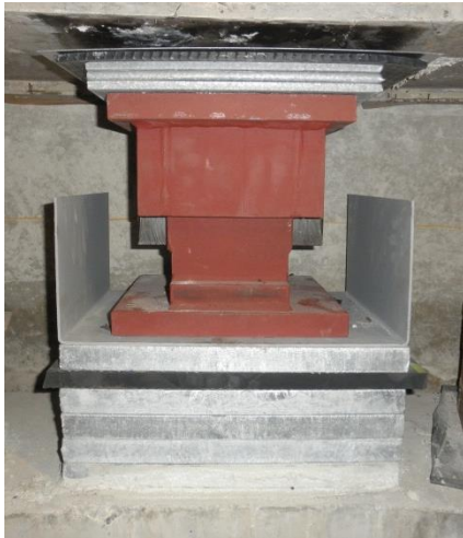
Bild 1: Unterstützungsstruktur mit Druckbegrenzer
