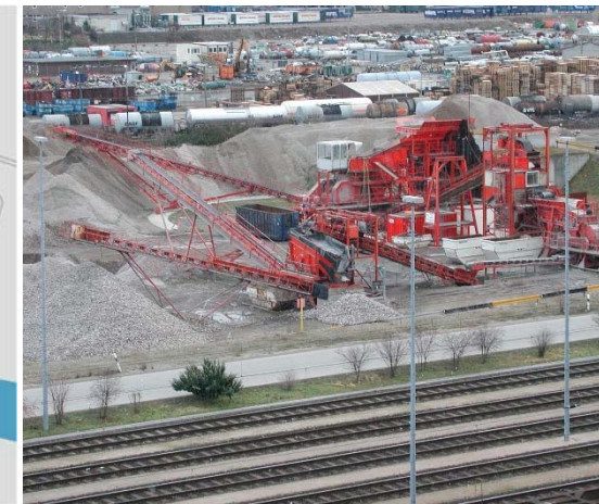
Boden- und Bauschutt-Recycling-Anlage
