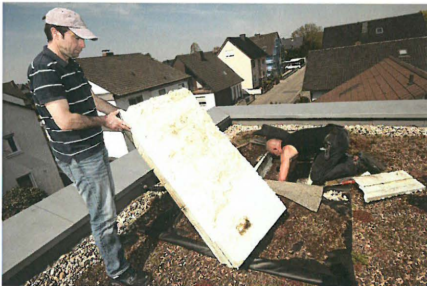
Bild 4: Entnahmestelle 1: Entnommene XPS-Platte 240 mm „Styrodur 3000 SQ“ – 4-lagig thermisch verschweißt
