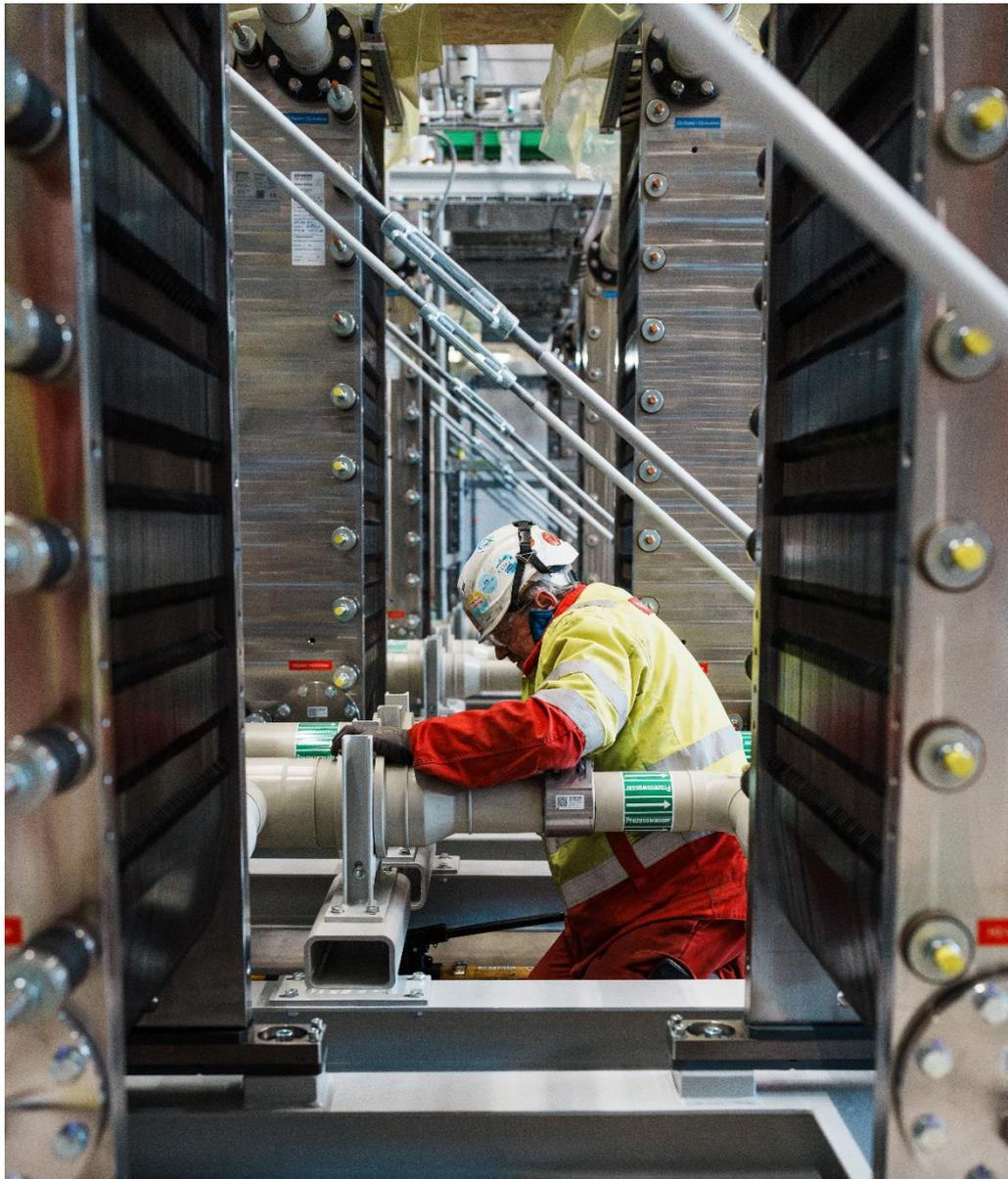
Die letzten Zentimeter sind Handarbeit: Monteure verbinden die einzelnen Elektrolyseur-Module miteinander. Bei Fertigstellung werden insgesamt 72 „Stacks“ eine Kapazität von 54 Megawatt haben.
