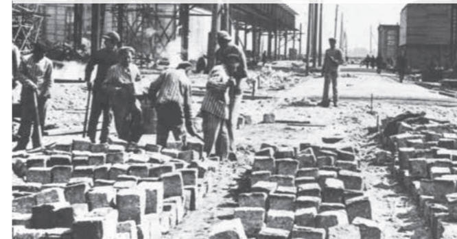
Straßenbauarbeiten im I.G. Werk Auschwitz-Monowitz, um 1943/44
