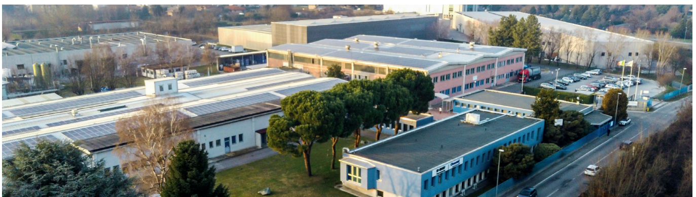
Una veduta aerea del sito produttivo di Giussano.
