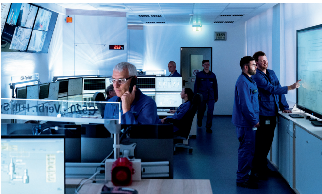
Una delle moderne stazioni di controllo digitalizzate del sito Verbund di Ludwigshafen, sede di tutte le informazioni relative agli impianti produttivi.
