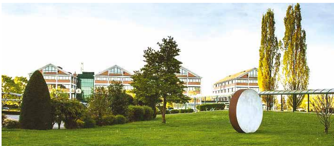
Il parco industriale di Cesano Maderno, l'headquarter di BASF in Italia
