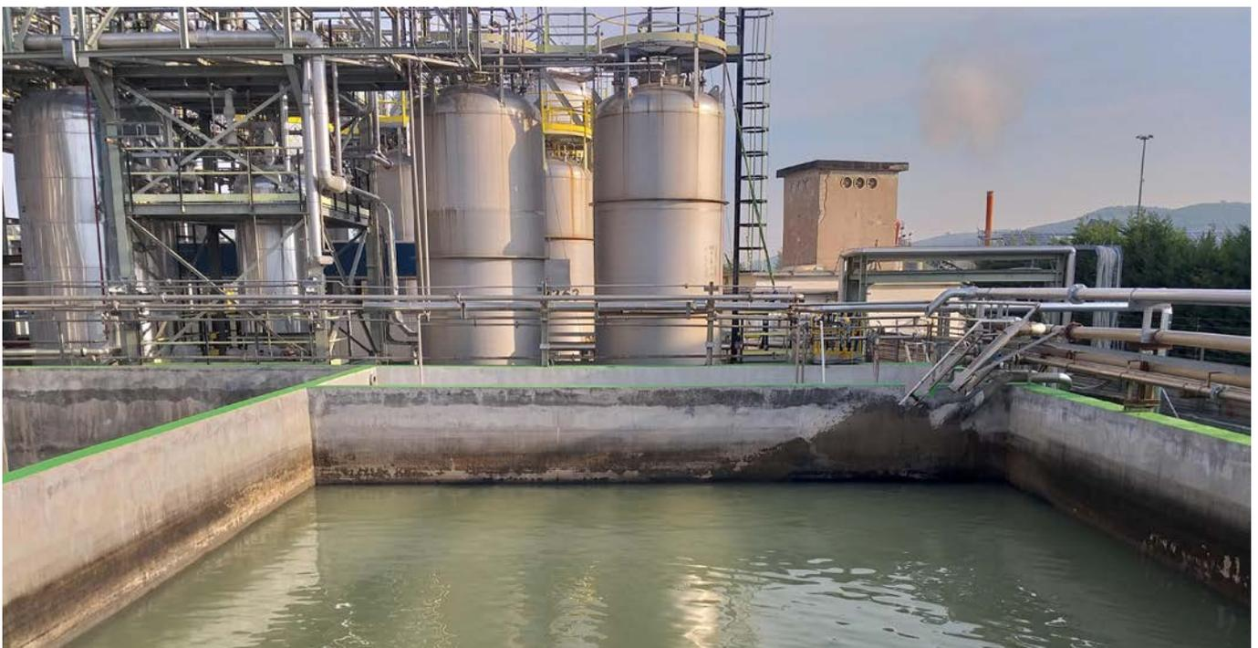
Pontecchio Marconi - Vasche di collettamento dove vengono programmate operazioni di campionamento, trattamento biologico o reinserimento nel ciclo produttivo.
