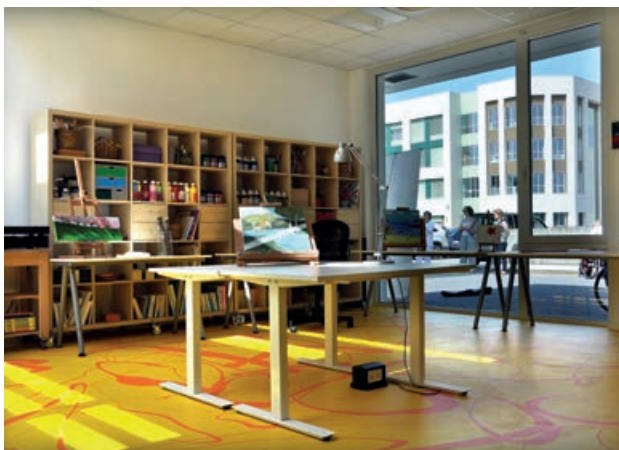
Uno dei locali di Spazio Vita dell'Ospedale Niguarda di Milano pavimentato con resine poliuretaniche colorate e sicure per coloro che si spostano su sedia a rotelle
