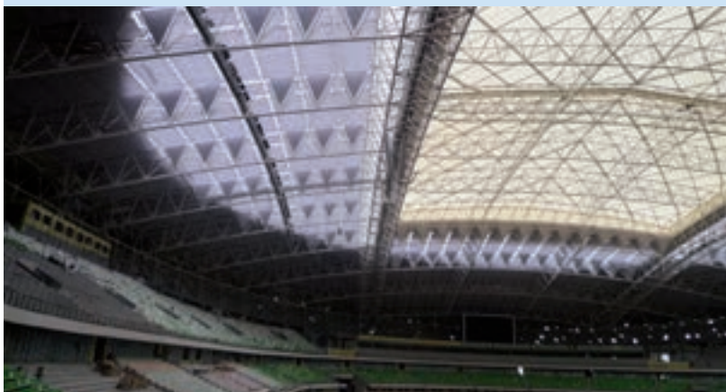
中国最大規模の開閉式スポーツスタジアムに設置された天井バップル
