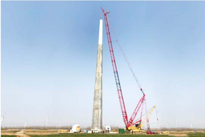
巴斯夫灌漿解決方案幫助 120 公尺高的鋼構混凝土混合塔架成功吊裝，標誌著風電引擎組的技術發展又增添一項里程碑。
